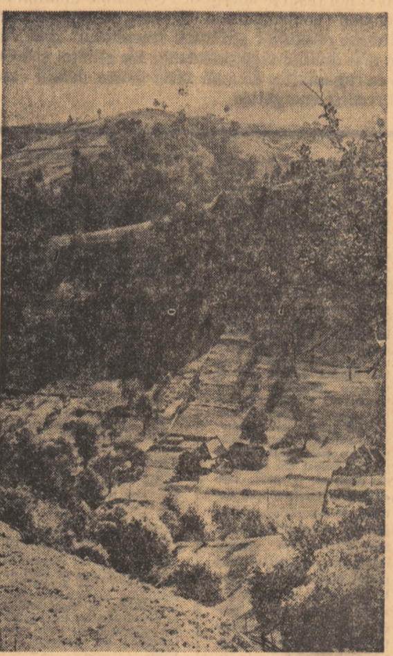
Planșă din Șantierul Brașului Foto: TRIFU DUMITRESCU
