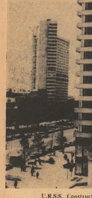
U.R.S.S. Construcții noi la Moscova
