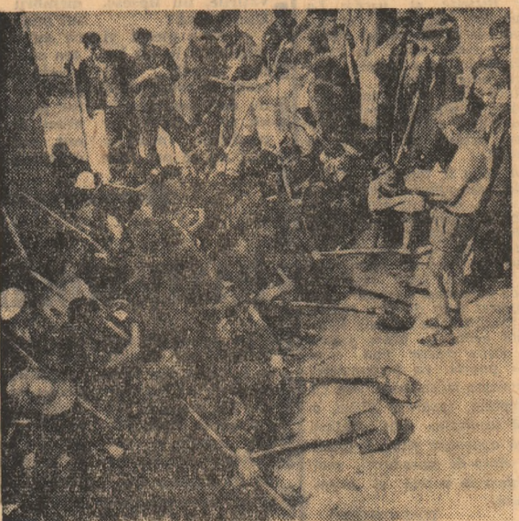
Înainte de începerea lucrului, brigadierii de la Ciorogirla sînt cunoscînd de regulile privind protecția muncii. Foto: GH. CUCU
