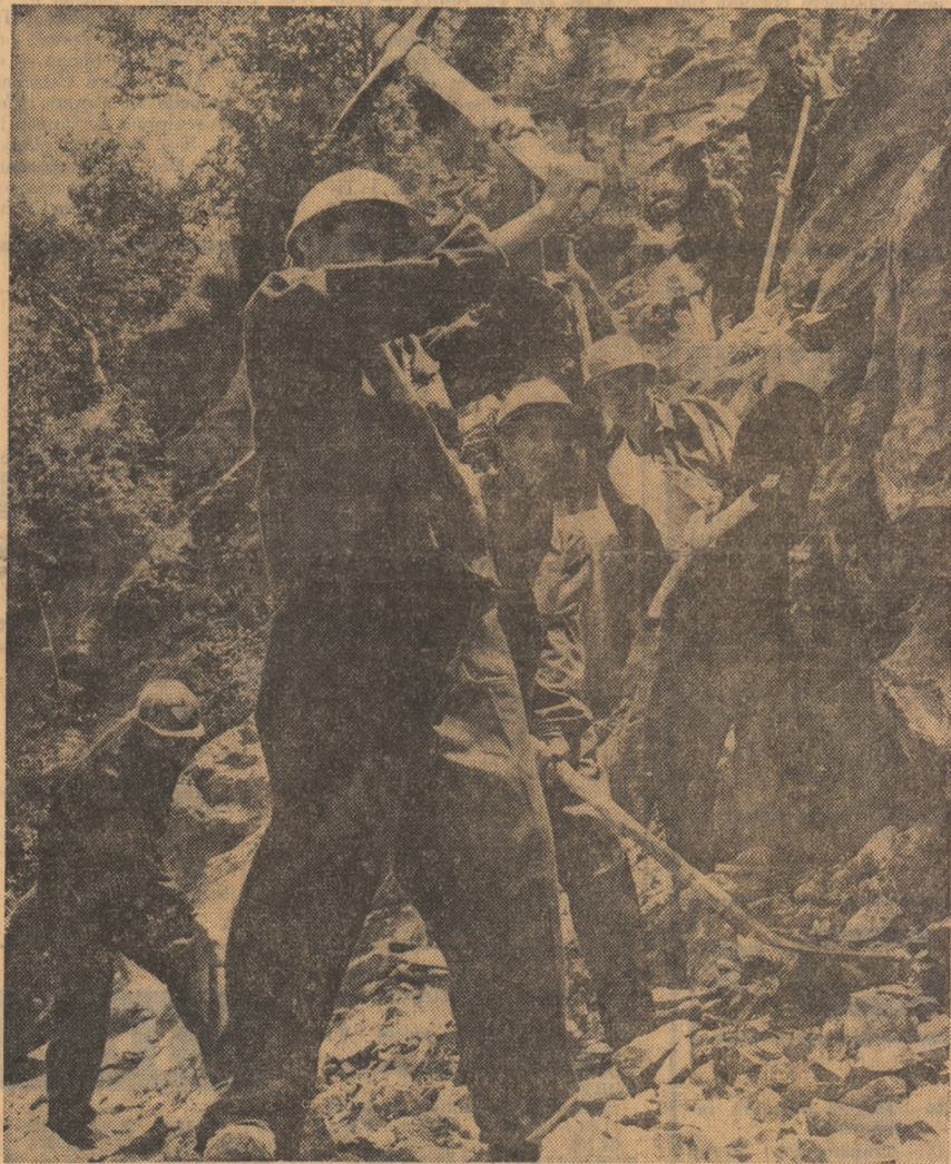
În deșelele țării și-au făcut reparația brigădierii. Și chiar din prima zi a sosirii lor pe acest șantier rutier, între Bumbestii și Lioezeni au început din nou să cadă stînci.
