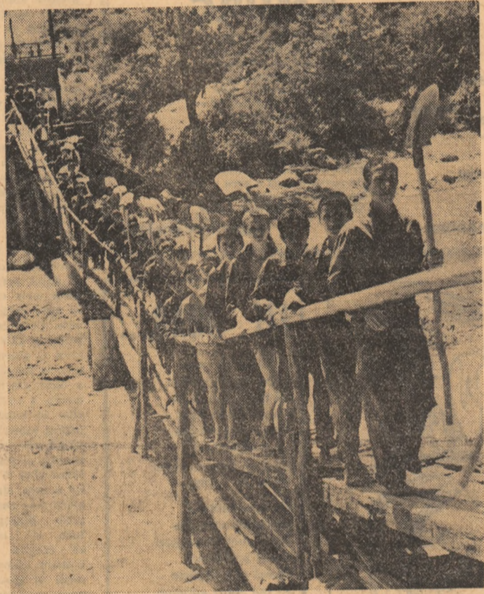
Incepe o nouă zi de muncă pe șantier
