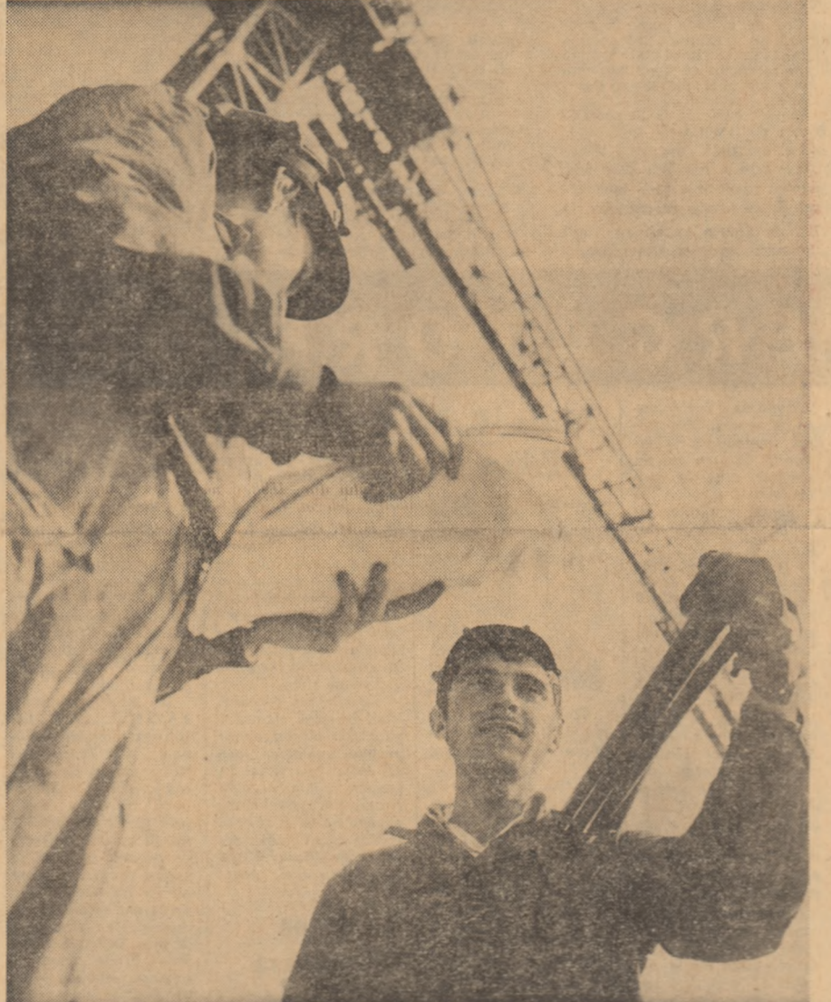
Lucrările de la Porțile de Fier — la cota celui mai înalt nivel al anului și entuziasmului muncii Foto: C. CONSTANTIN
