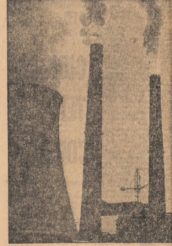
Termocentrale — unități industriale care transsubstanțiază bogățiile milenare
