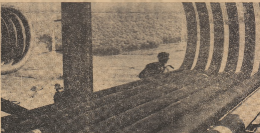
Pe șantierul Centralei termoelectrice din Deva
