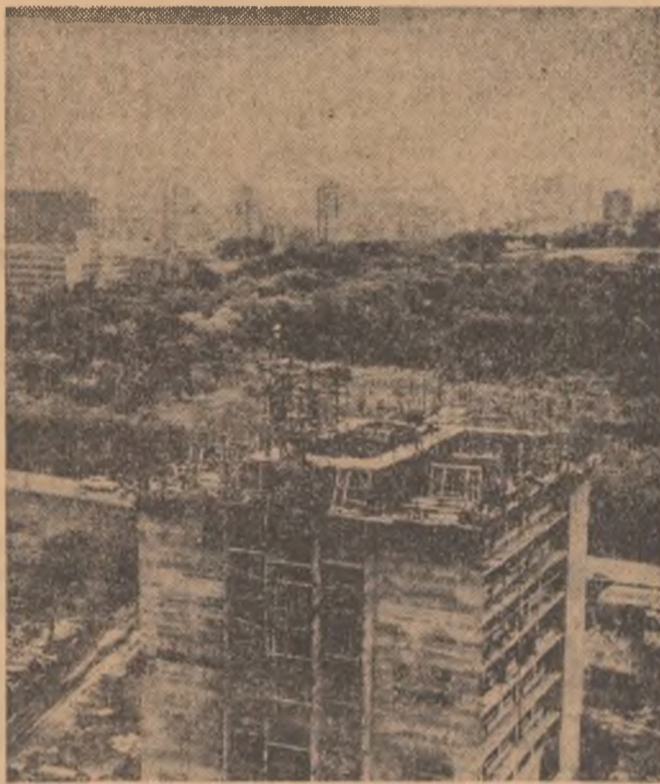
Pe șantierul complexului de locuințe din Burgas
