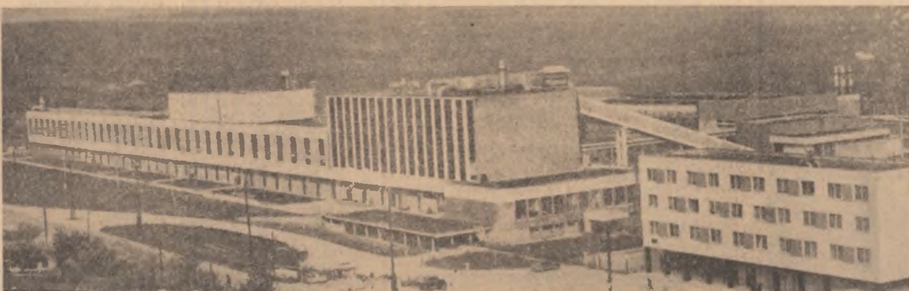
Vedere exterioară a combinatului de industrializare a lemnului din Bacău.
