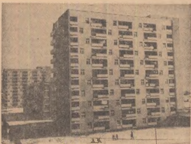
Nou construcții în Brazilia lui Novac — Craiova
