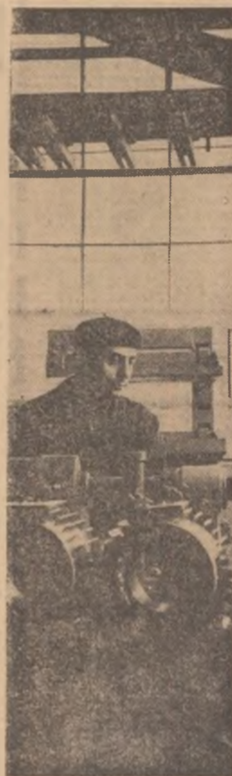
Uzina de motoare electrice Pitești. Muncitorul Cojocaru Ilie, efectuînd operația de presare a rulmenților pe rotoare și poziționarea statoarelor pe dispozitiv
