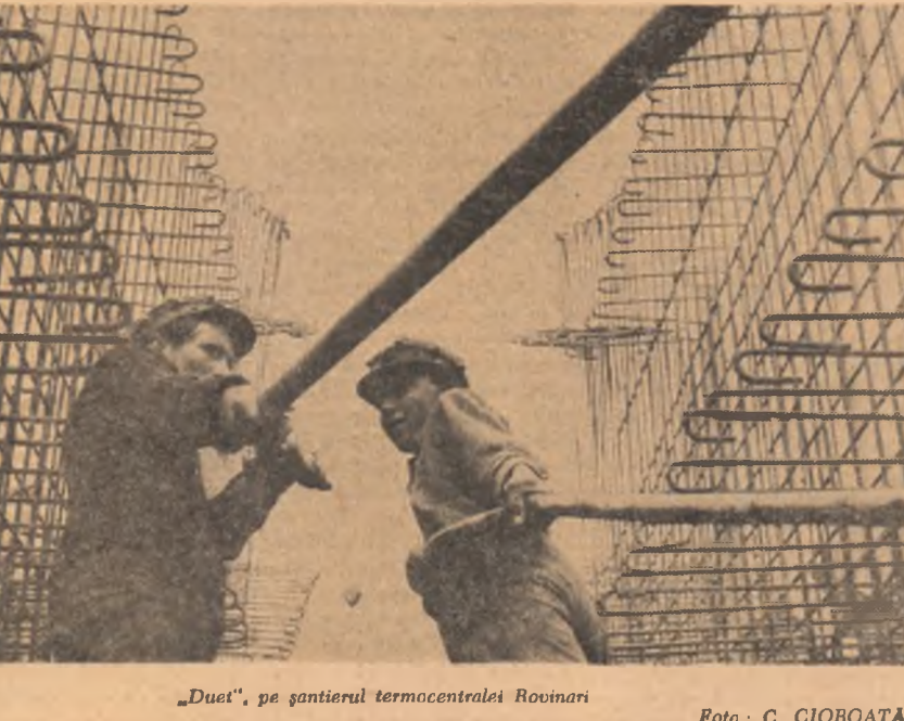
„Duet”, pe șantierul termocentralei Rovinari. Foto: C. CIOBOATA
