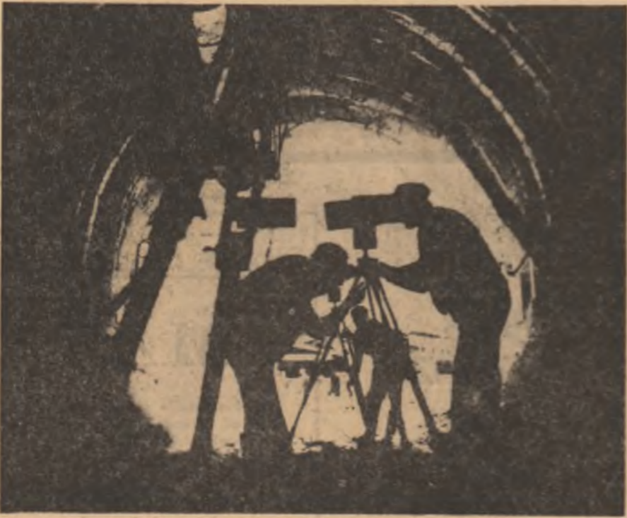
Geometrie desenata in piatra muntelui: se verifică axul galeriei la aducțunea principală a hidrocentralei de pe Lotru.
