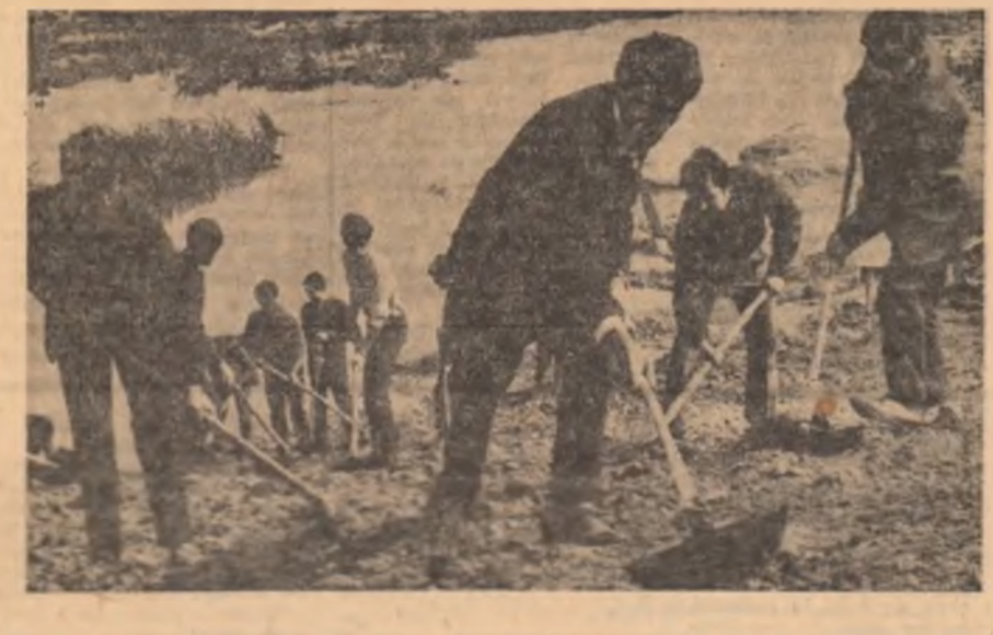
Din nou pe șantierelor de muncă patriotică
