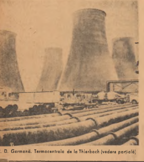
R. D. Germană. Termocentrala de la Thierbach (vedera parțială)
