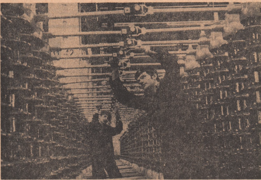
„Electroputere” — Craiova: Dumitru Verdeș și Ion Verița — absolvenți ai școlii profesionale, promoția 1969 — de la fabrica de aparatură, lucrează la separatoarele de 110 KV. Foto: O. PLECAN
