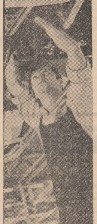
Ion Neculce — mecanic la banda aeriană de montaj — unul dintre cei ce-și pun semnătura pe actul de naștere al „Daciei“
