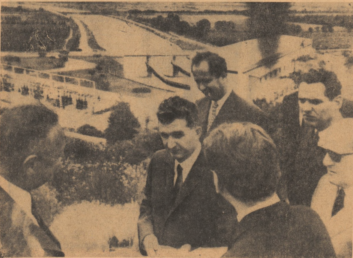
Scurtă oprire pe un platou ce domină panorama instalațiilor stației de pompare de la Pichegu.
