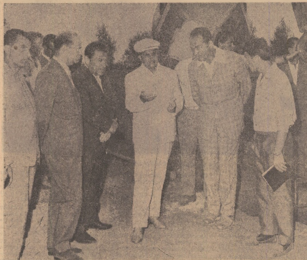
La șantierul stațiunii Olimp
