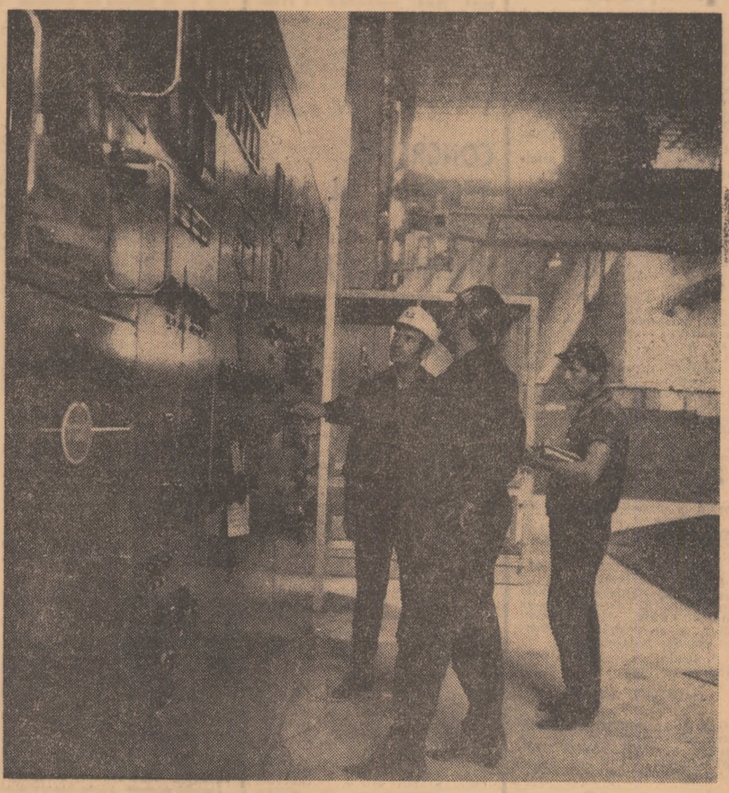
O fotografie „banală”: un tablou de comandă, în aparență, ca oricare altul. Dar numai în aparență. În realitate o fotografie istorică: primul tablou de comandă instalat și intrat în funcțiune la Hidrocentrala Porțile de Fier. Deocamdată, el înregistrează semnalele unor probe. În curînd le va înregistra pe cele ale fluxului producție. Foto: O. PLECAN
