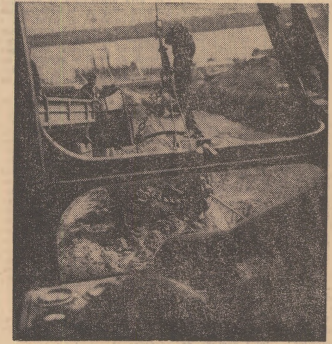
În aceste zile, lucrările pe șantierele de irigații cunosc un ritm intens
