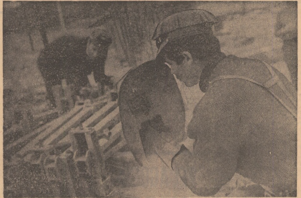
Pe șantierul Hidrocentralei de la Rogojelu
