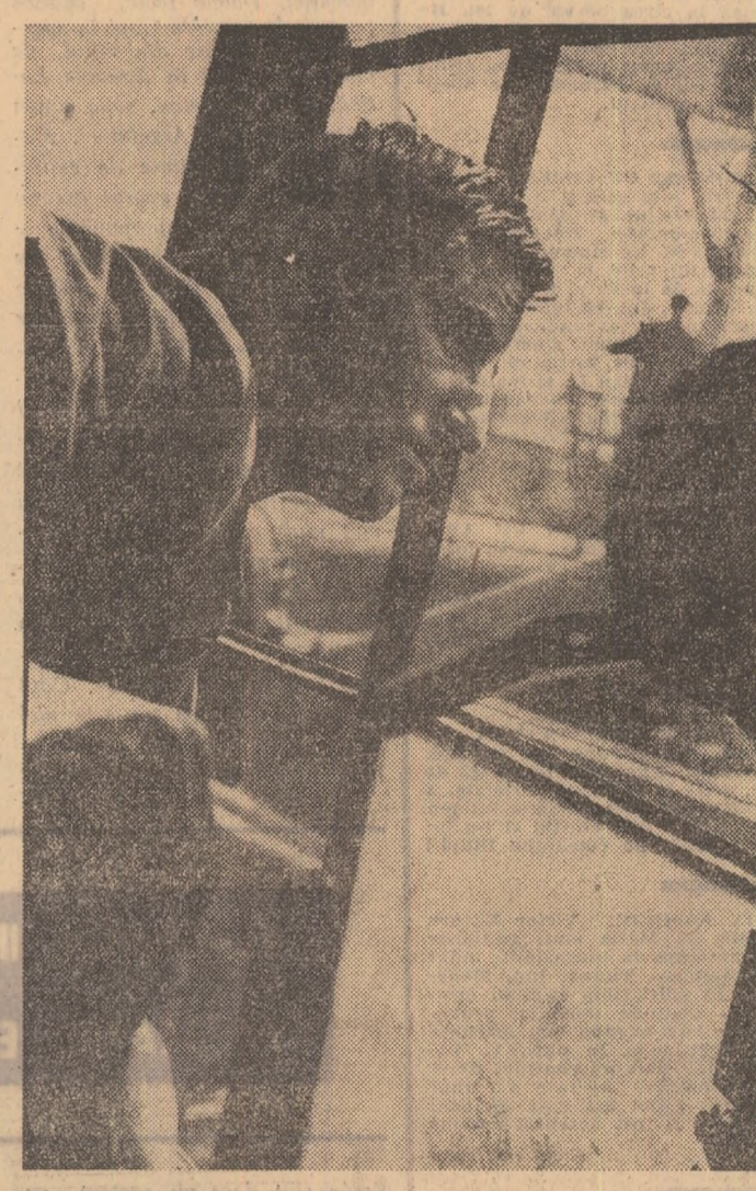
Pe platforma uzinei „1 Mai” din Ploiești se efectuează probele la o nouă instalație destinată exportului.
