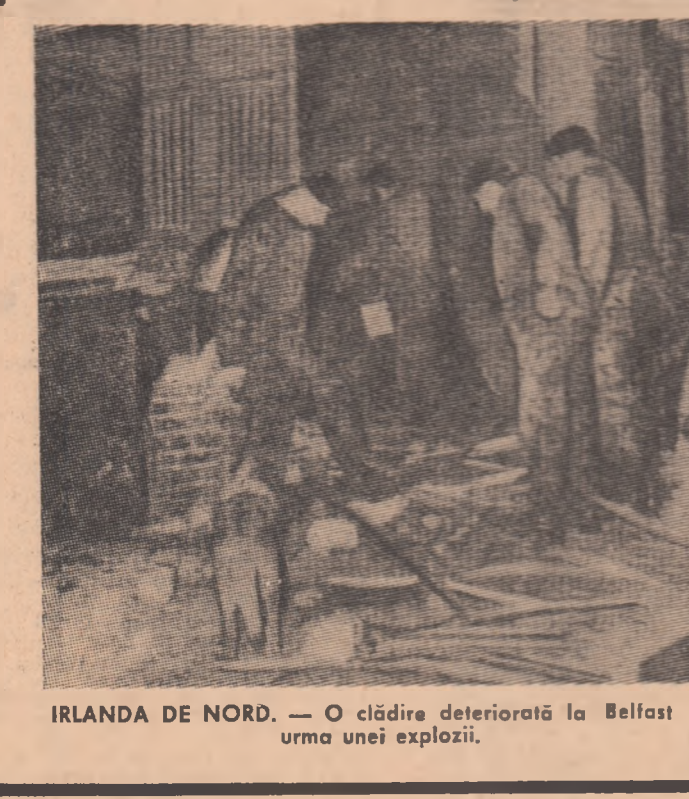
IRLANDA DE NORD. — O clădire deteriorată la Belfast în urma unei explozii.
