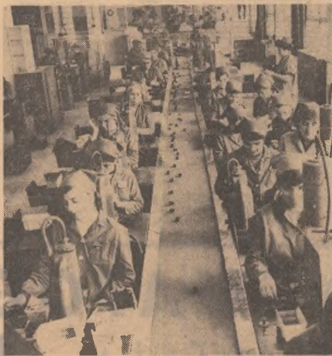
Secență de lucru la banda de montaj-instalații a Fabricii Electroaparataj-București. Foto: C. CIOBOATA
