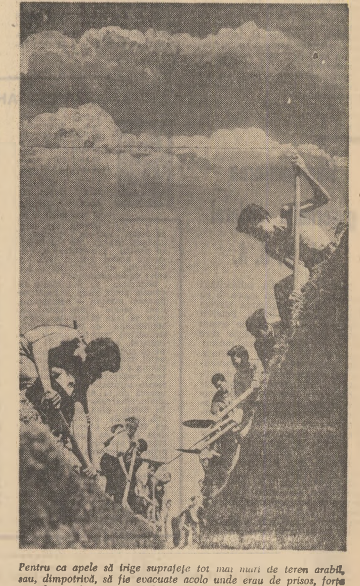
Pentru ca apele să trîge suprafețe tot mai mari de teren arabil, sau, dimpotrivă, să fie evacuate acolo unde erau de prisos, forța tinerilor a fost prezentă la executarea unor ample lucrări de hidroameliorații
