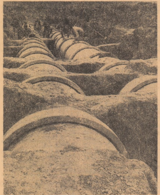
Pentru a străbate călusele sud al Dobrogei, riul cel nou curge pe albie de pământ și beton, urcă pe conducte al căror diametru permite omului să se deplaseze în voie
