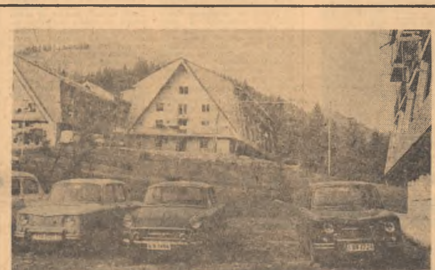
La Voineasa, pe Lotru
