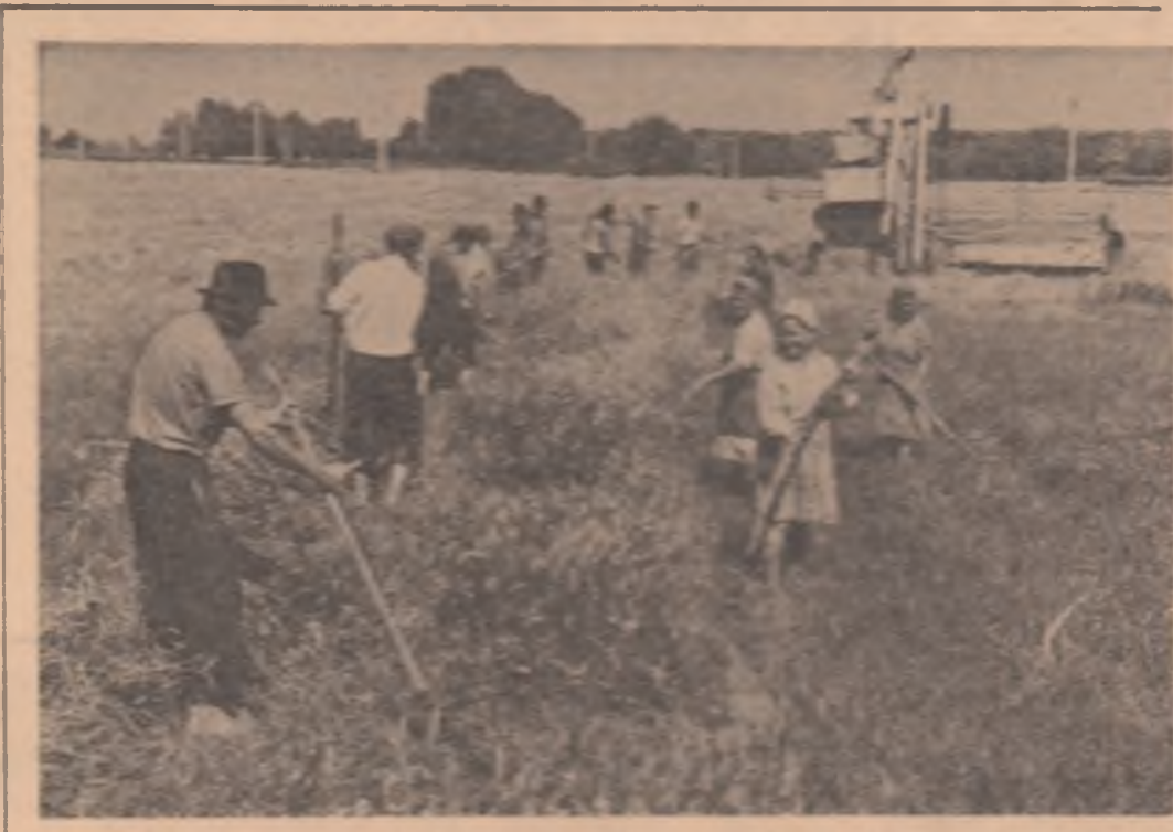
Ieri s-a lucrat din plin pe șantierul hidrocentral de construcție, cooperanții sting gîul de pe porțile unitii nu se poate realiza cu mijloace mecanice. Foto: O. PLECAN
