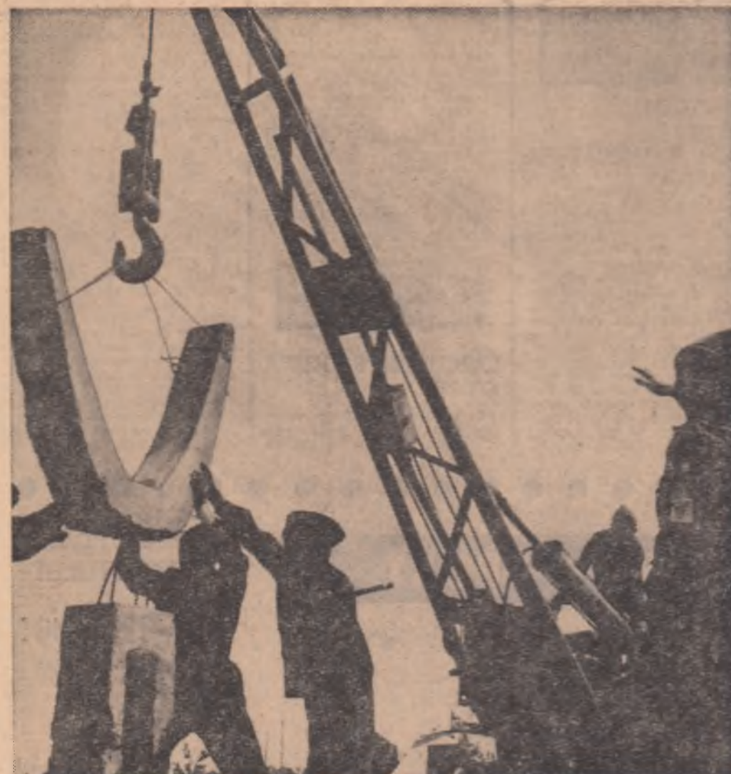
O imagine de sezon pe șantierul tineretului deschis recent în „Terasa Brăilei”.
