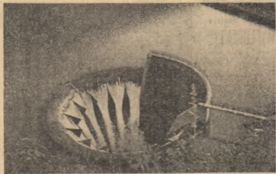
R. S. F. IUGOSLAVIA. — Vedere a centralei hidroelectrice Gabcikovo construită pe locul cu ocaziile romne
