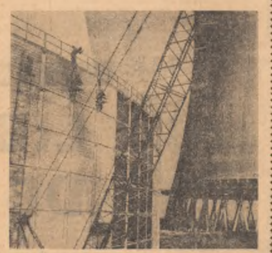
R.P. UNGARA. — Lucrări de construcții la un important obiectiv termoelectric.
