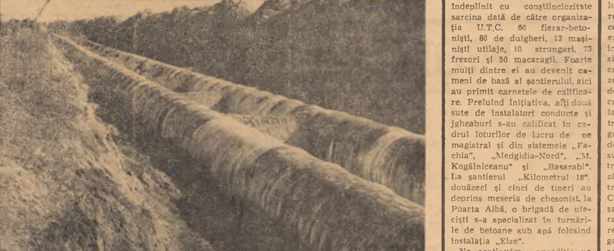
ȘANTIERUL DE IRIGAȚII GĂLAȚUI — CĂLĂRAȘI: Aproximativ o mie de tineri brigadieri au deschis drumul cel nou al apei, fertilizînd Bărdaganul — șeptzeci de mii de hectare.
