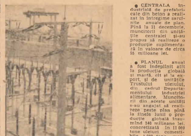
Stația de transformare.
