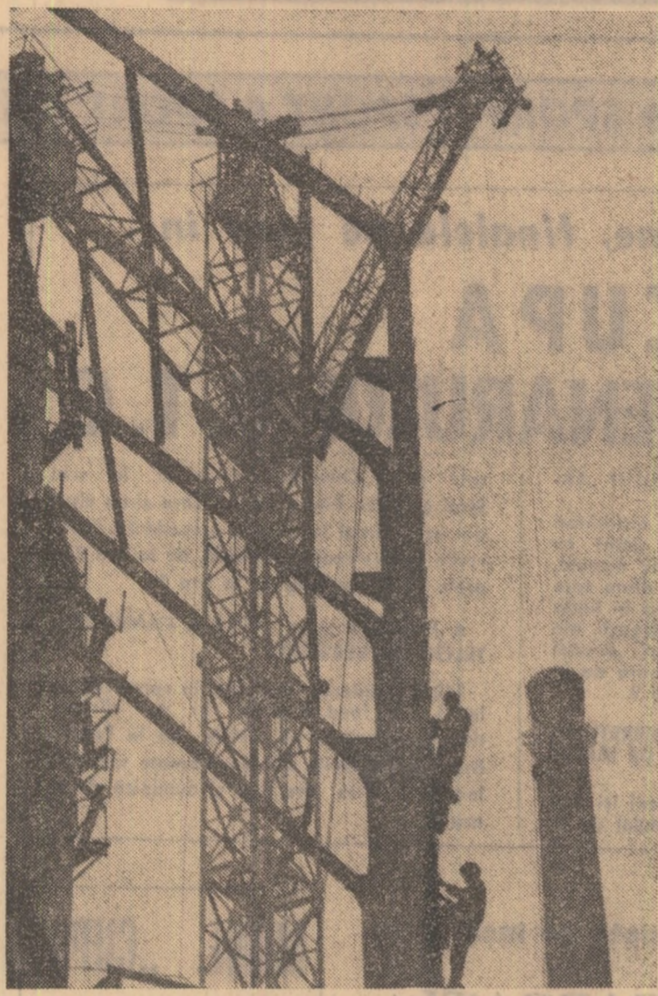
Hunedoara. Tineri pe șantier.
