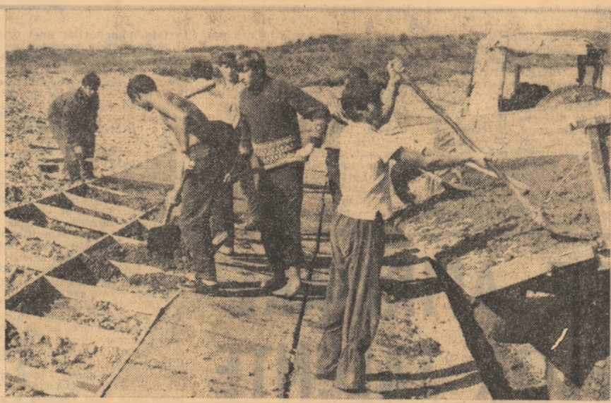
Așa se pregătesc „zale” pentru „armura” așezată temeinic pe pieptul digului. Fotografiele: VALENTIN BUZLEA
