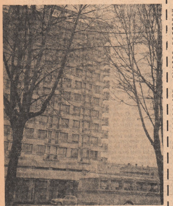
Noul hotel „Zimbru” din Cimpulung Moldovenesc
