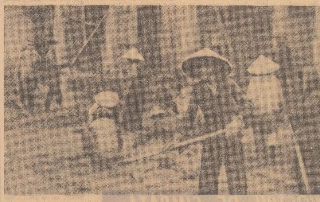
Locuitorii Hanoiului lucrează intens la reconstruirea cartierelor care au avut de suferit de pe urma războiului.
