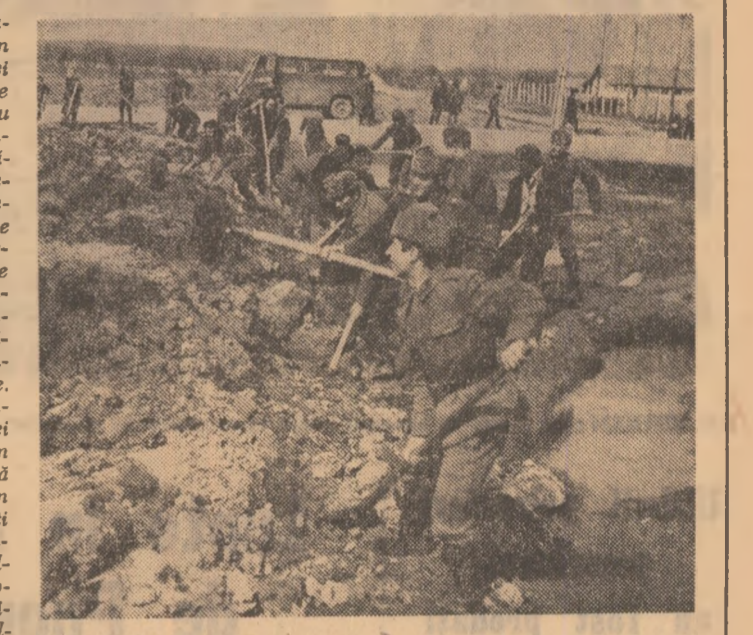
Alături de populația comunei Grozești, ostașii lucrează la ridicarea unui dig pentru prevenirea inundațiilor.
