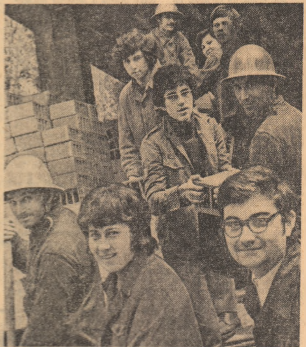
Un zîmbet cu multiple semnificații. Studenții Facultății de căi ferate, drumuri și poduri își construiesc ei înșiși clădirea facultății în care vor învăța și se vor pregăti ca viitori specialiști.
