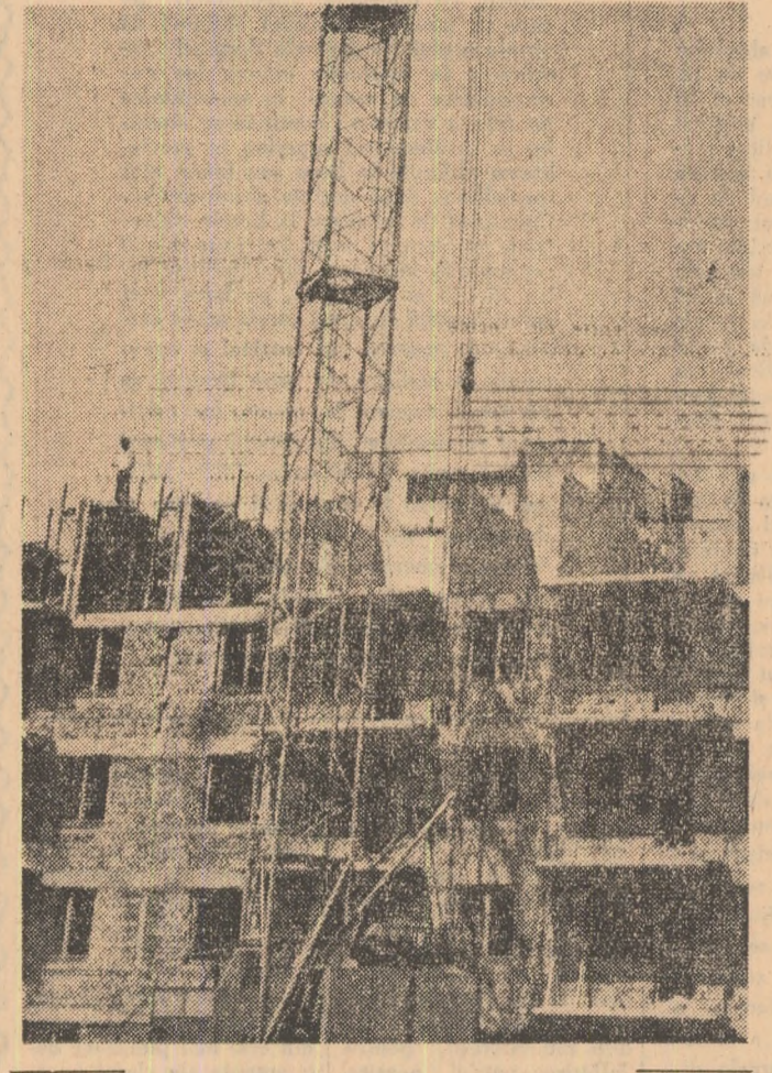
Șantier de construcții de locuințe în orașul Slatina.
