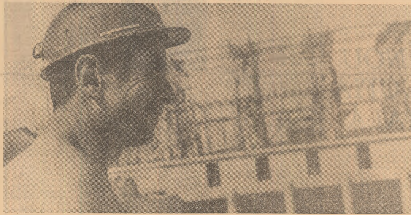
MHAI FLOREA: În construcția aceasta (Sistemul de irigații de la Corabia-Turnu Magurele) am încorporat peste 5 000 metri cubi de betoane și 85 000 de kilograme oțel-beton. Și multe, multe zile de muncă încordată. Foto: GH. CUCU
