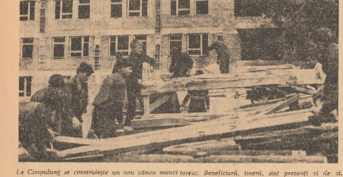
La Cimpulung se construiește un nou cămin muncitoresc. Beneficiarii, tinerii, sînt prezenți zi de zi.
