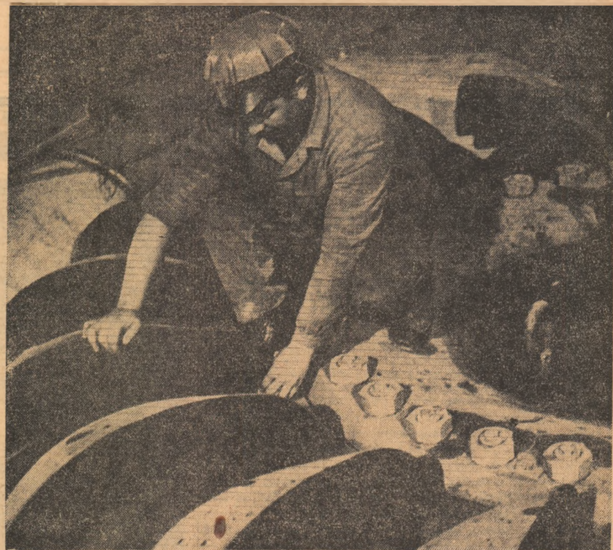
Lotru. Reporterul a surprins un moment important: se montează flotorul turbinei nr. 3. Foto: GH. CUCU
