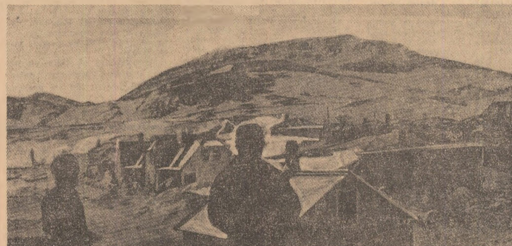
Distrușă în urmă cu un an de o erupție vulcanică, insula islandeză Heimaey revine la viață. 2.000 din cei 5.300 de foști locuitori ai ei s-au reintors pe meleagurile lor, în locuințele reconstruite.
