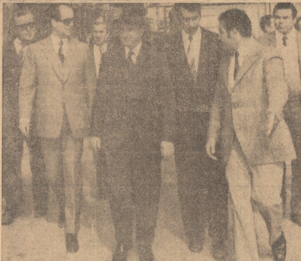
Pe șantierul rafinăriei Zawia
