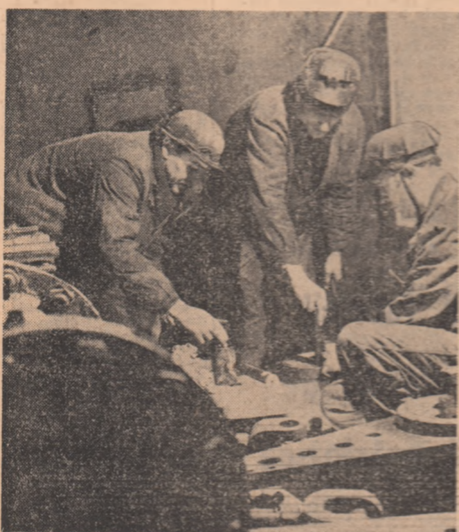
Echipa de montori ai „Energomonta” — București, condusă de maestrul Mezel Iosif, obține succese de seamă pe șantierul centralei hidroenergetice de la Rm. Vilcea
