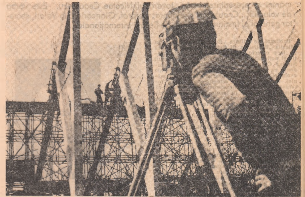
Pe șantierul Școlii polivalente continuă montajul prefabricatelor grele.
