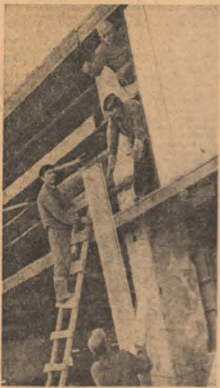
Se montează profile la frontonul halei
