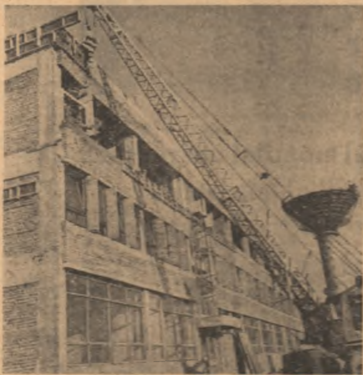
Constructorii halei 20 B. 2 au deja un etaj de puse în
