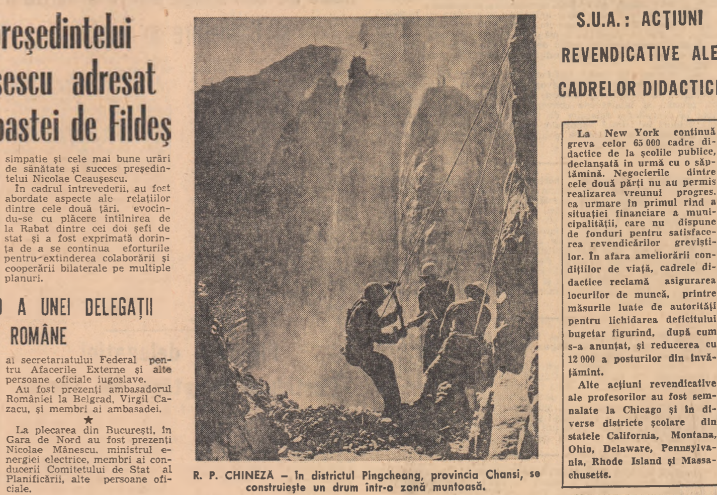
R. P. CHINEZA — În districtul Pingcheang, provincia Chensi, se construiește un drum într-o zonă muntoasă.
